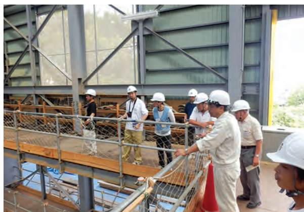
勝興寺修理現場見学
