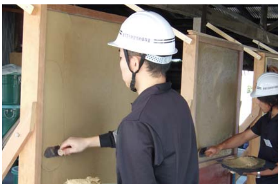
大津壁塗り実技
