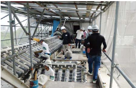
姫路城修理現場見学
