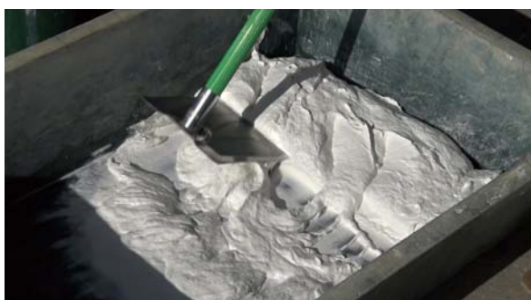
漆喰の出来上がり
